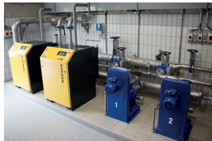
Überschussschlammumpen für Vorlagebehälter 1&2
