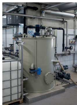
Ansetzstation für Flockungshilfsmittel
